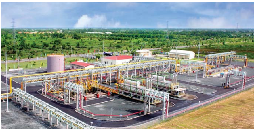
Công ty Khí Cà Mau đã cấp trên 10,86 tỷ m 3 khí cho Nhà máy Điện Cà Mau 1 & 2, Nhà máy Đạm Cà Mau. Ảnh: PV GAS
