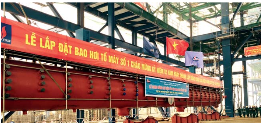
Bao hơi tổ máy số 1 Nhà máy Nhiệt điện Thái Bình 2 đã được lắp đặt thành công. Ảnh: PVN
