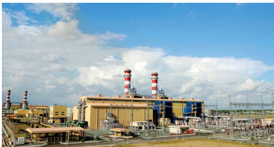
Nhà máy Điện Nhơn Trạch 2. Ảnh: CTV
