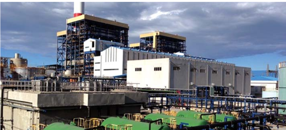
Nhà máy Nhiệt điện Vũng Áng 1. Ảnh: CTV
